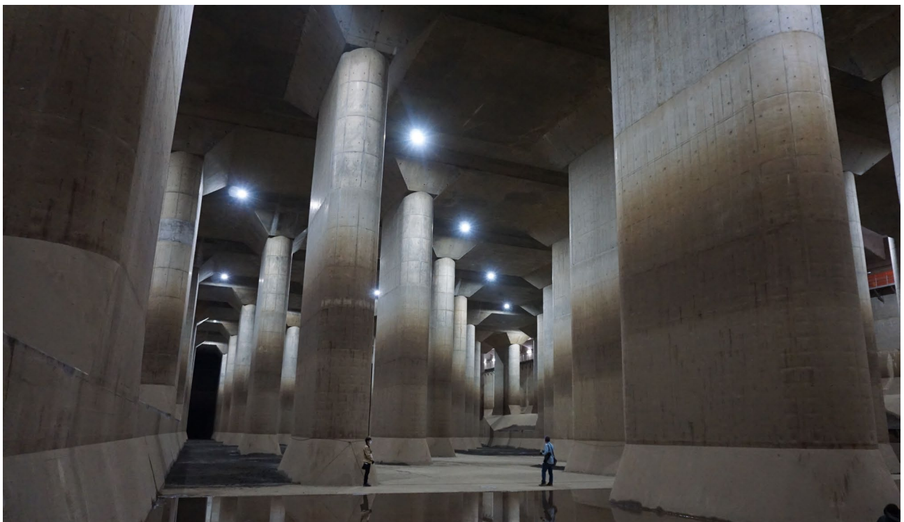
Der Metropolitan Outer Area Underground Discharge Channel ist ein gigantisches System aus riesigen Tunneln, Schächten und Wassertanks zum Schutz vor Überflutungen. Im Bild: das riesige Überflutungsbecken von Kasukabe (Nähe Koshigaya, Präfektur Saitama), Ausmaße: 177m lang, 78m breit, 18m hoch.
