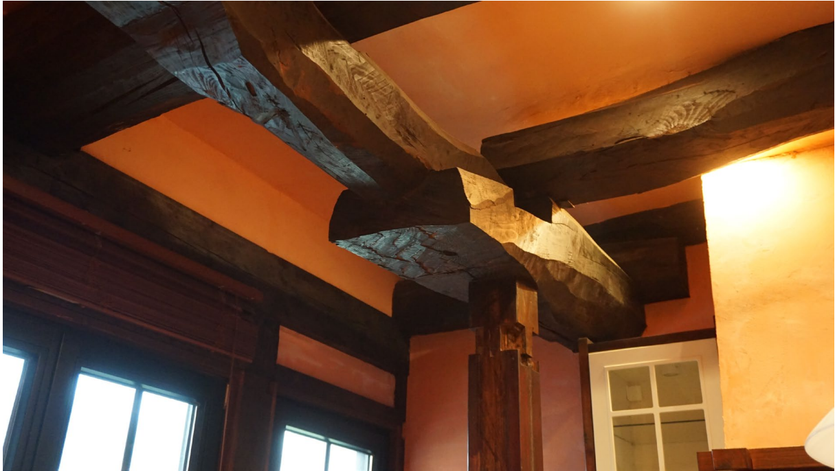
Originale Holzbalkenstruktur im Innern
