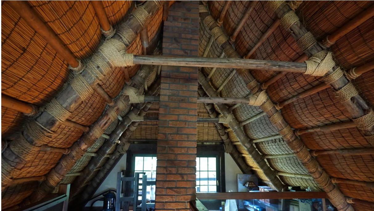
Die Dachkonstruktion im Yellow-House
